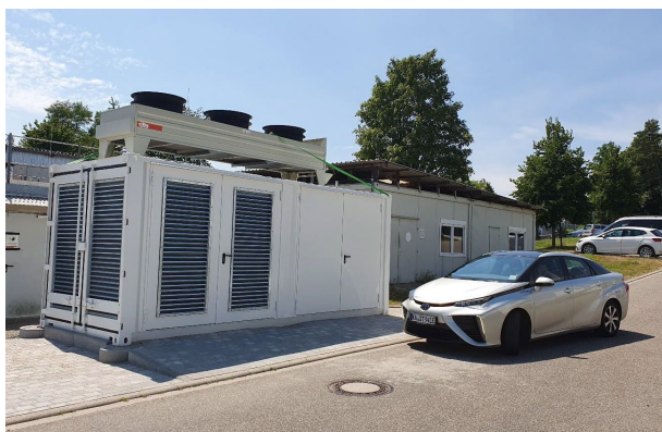
Рис. 5. Металлогидридный термосорбционный компрессор (30–450 бар, 22,5 нм 3 /ч) в составе водородной заправочной станции, разработанный в рамках проекта ЕС «COSMHYS»
