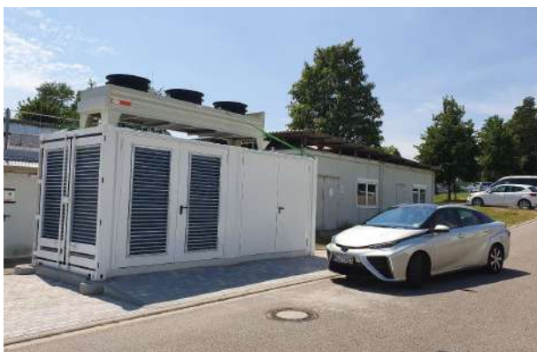
Рис. 5. Металлогидридный термосорбционный компрессор (30–450 бар, 22,5 нм 3 /ч) в составе водородной заправочной станции, разработанный в рамках проекта ЕС «COSMHYS»
